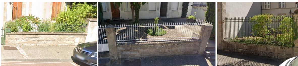
Exemple autorisé de mur surmonté de dispositif de barreaudage, rue Feullin
