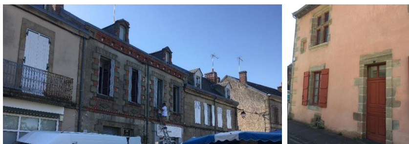
Exemple d'encadrement de façade, de génoise et de fenêtre à meneaux à protéger.
