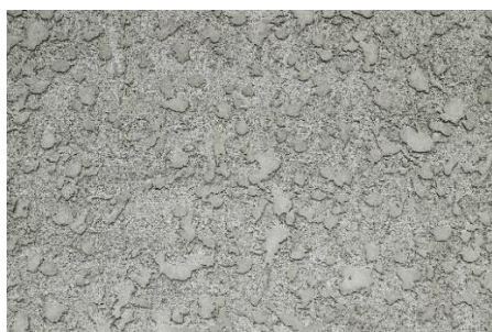
Exemple de finition de type « petit suisse écrasé »
