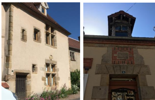
Exemple d'éléments de décors sculptés sur façade et d'encadrement d'ouverture en pierre à maintenir visible et à préserver.
