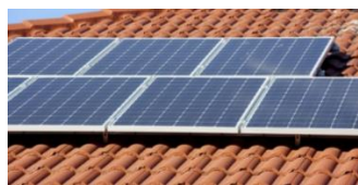
Panneaux posés parallèlement à la pente du toit
