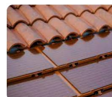
Panneaux posés sans respecter la pente du toit
